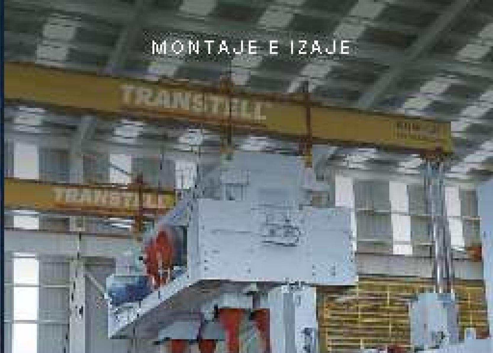
Combinando equipos certificados como: manes hidráulicos (Gantry), cilindros hidráulicos con cables (tira) y sistemas de empuje-deslizamiento y líneas asociadas, podemos ofrecer numerosas alternativas para: montaje, levantamiento y deslizamiento, colocación de placas (bedding bedding), re-ubicación de carga y movimientos para el ingreso o salida de equipo de una bodega o banco de almacenamiento.
